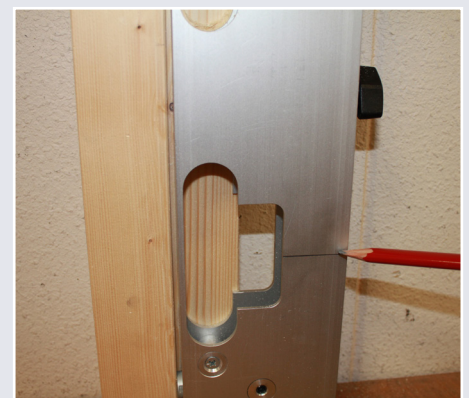
Afb. 14 Afschrijven hart Sluitplaat
