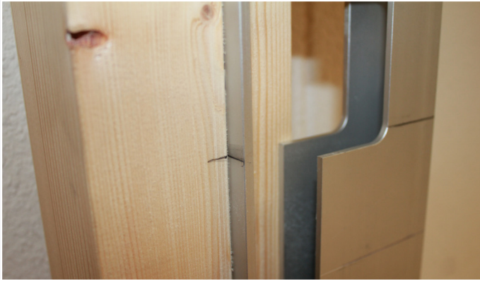
Afb. 8 Graveerlijn gelijk zetten
